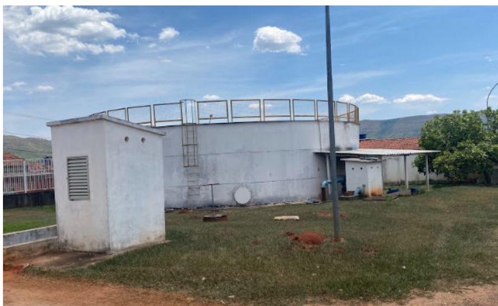
Figura 37 – Reservatório R-3 ETA
