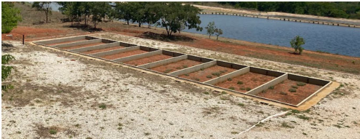
Figura 68 – Leito de secagem da ETE
