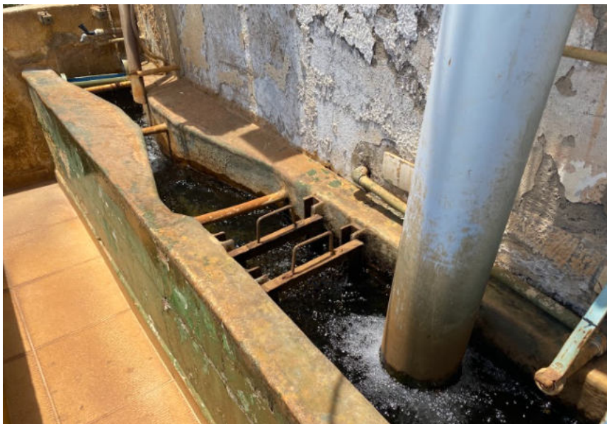
Figura 27 – Calha Parshall ETA Andorinhas
