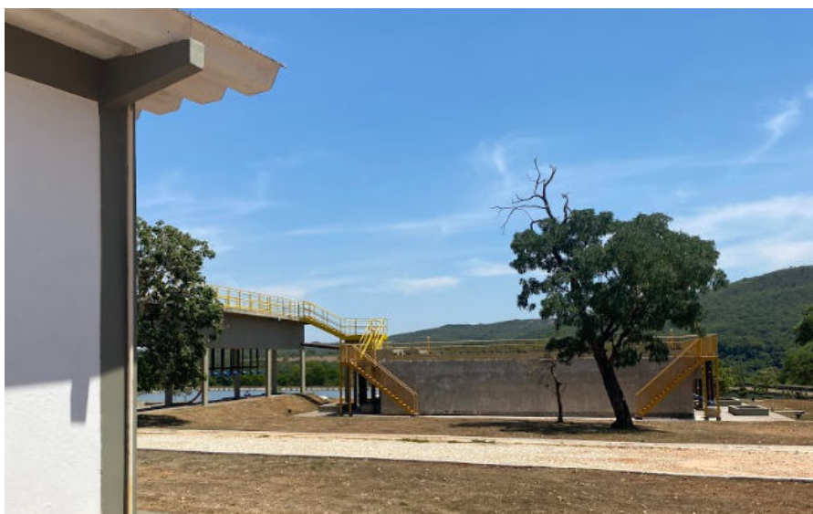
Figura 63 – Visão geral da ETE de Pirenópolis
