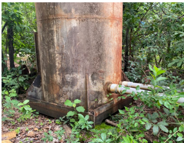
Figura 48 – Base do reservatório (Capela do Rio do Peixe)
