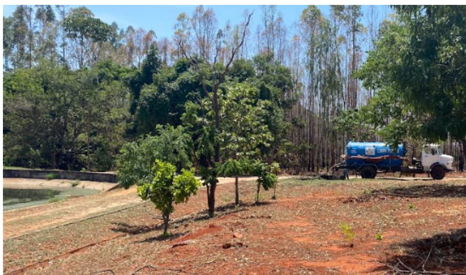
Figura 71 – Caminhão limpa-fossa despejando efluente na ETE
