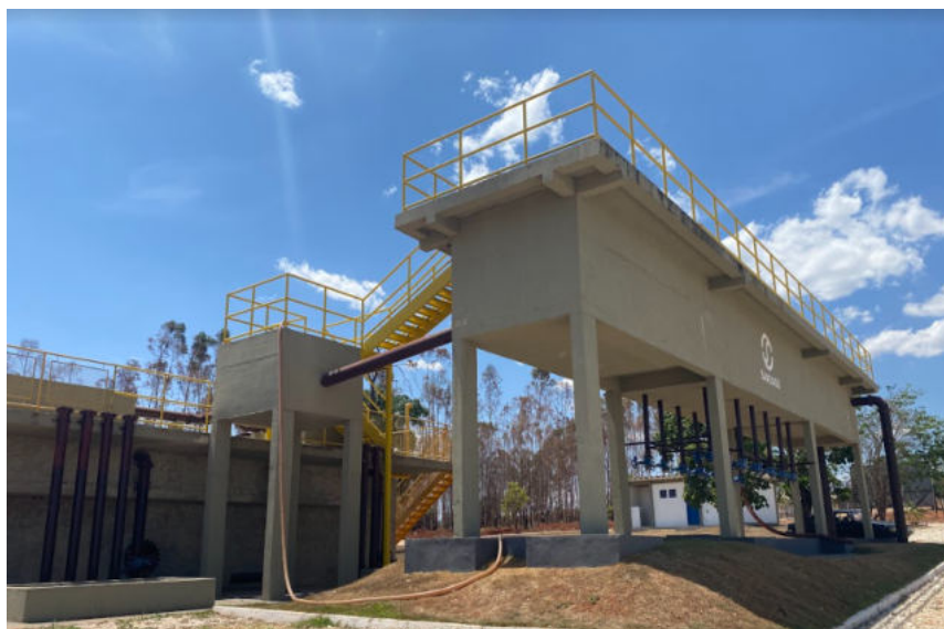
Figura 64 – Visão geral do desarenador da ETE (Sede)
