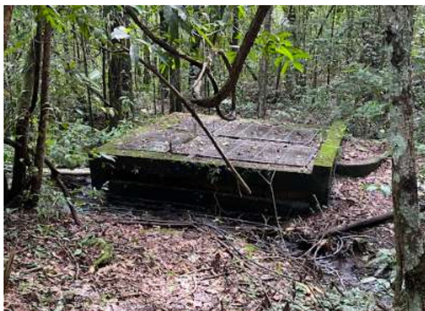
Figura 23 – Ponto de captação em mina d'água – Morro do Frota (Sede)
