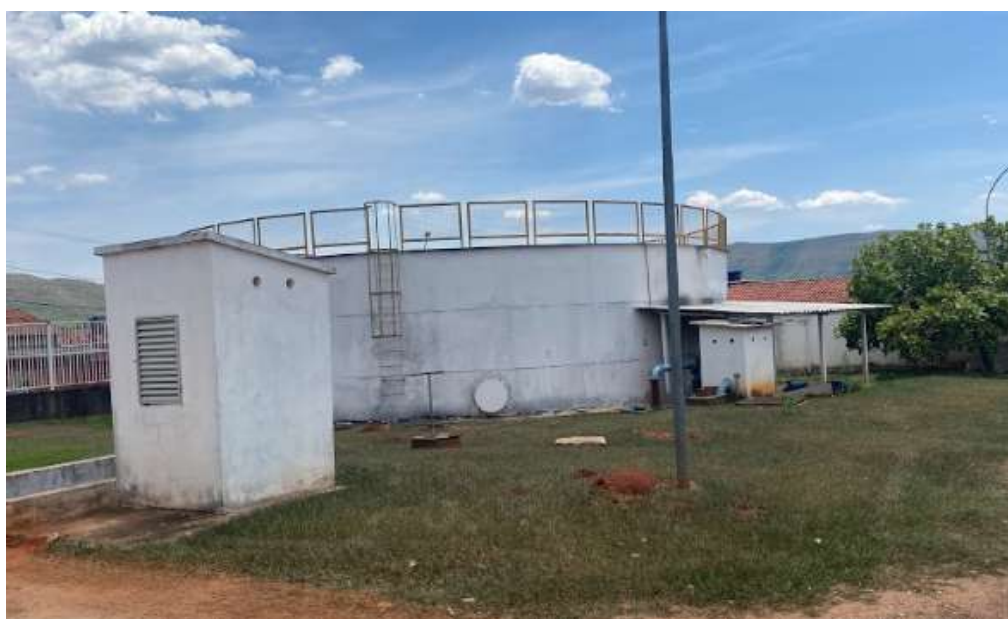
Figura 37 – Reservatório R-3 ETA
