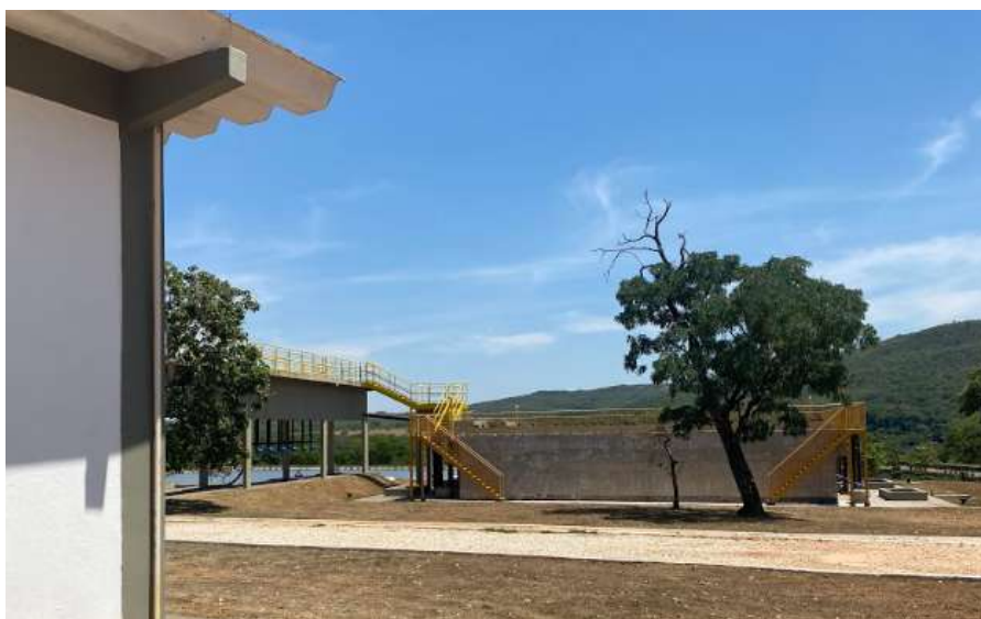
Figura 63 – Visão geral da ETE de Pirenópolis
