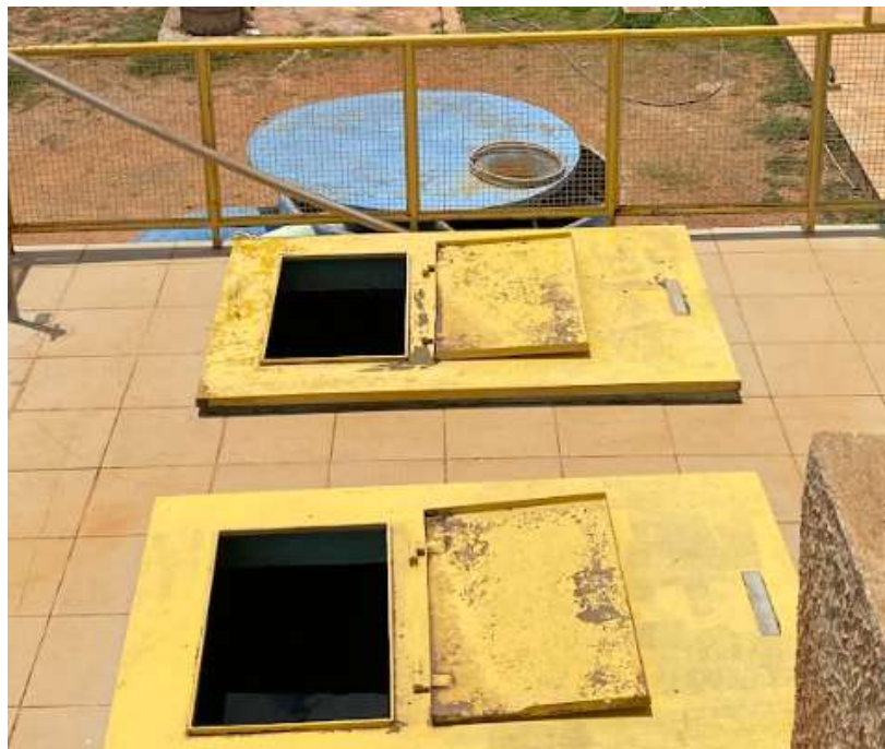
Figura 29 – Filtros de concreto e tanque de contato ao fundo
