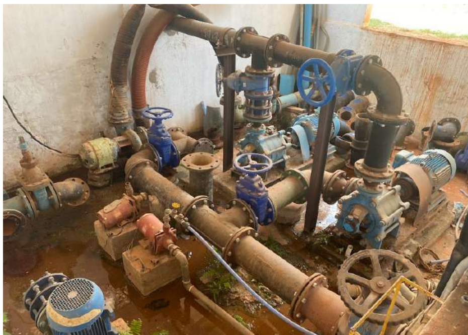
Figura 34 – EEAT Santa Bárbara (Sede)
