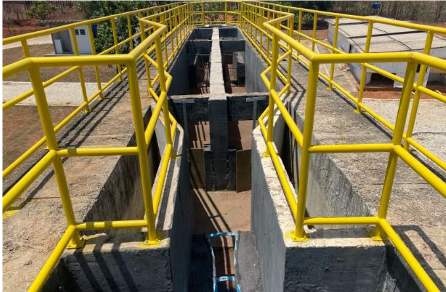
Figura 66 – Desarenador e calha Parshall da ETE
