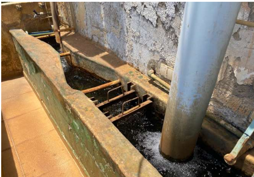
Figura 27 – Calha Parshall ETA Andorinhas
