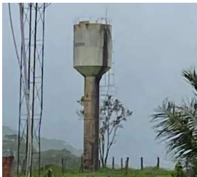
Figura 54 – Reservatório (Santo Antônio)
