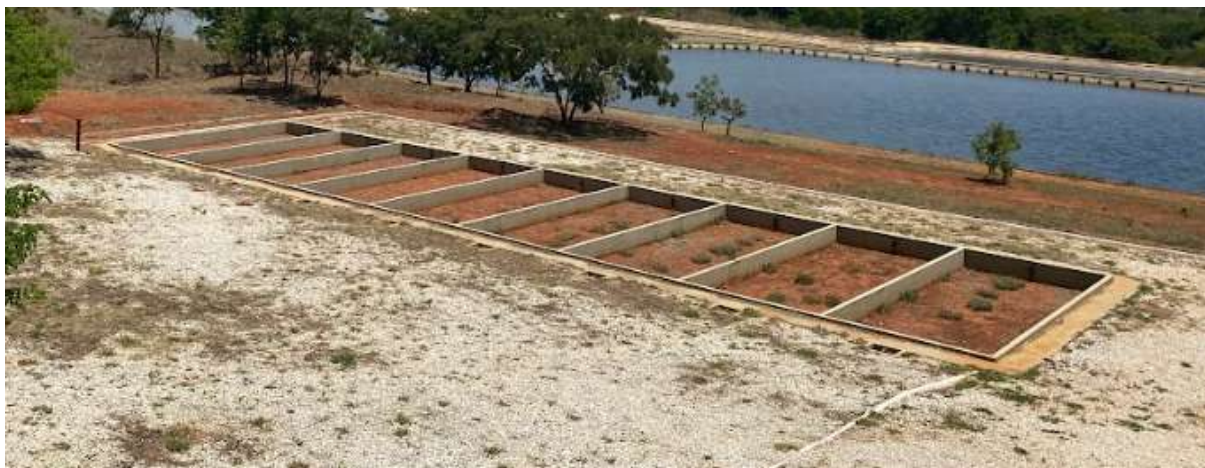
Figura 68 – Leito de secagem da ETE
