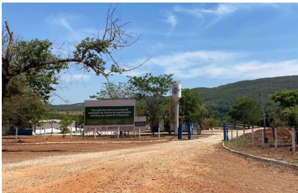
Figura 57 – Entrada da ETE de Pirenópolis
