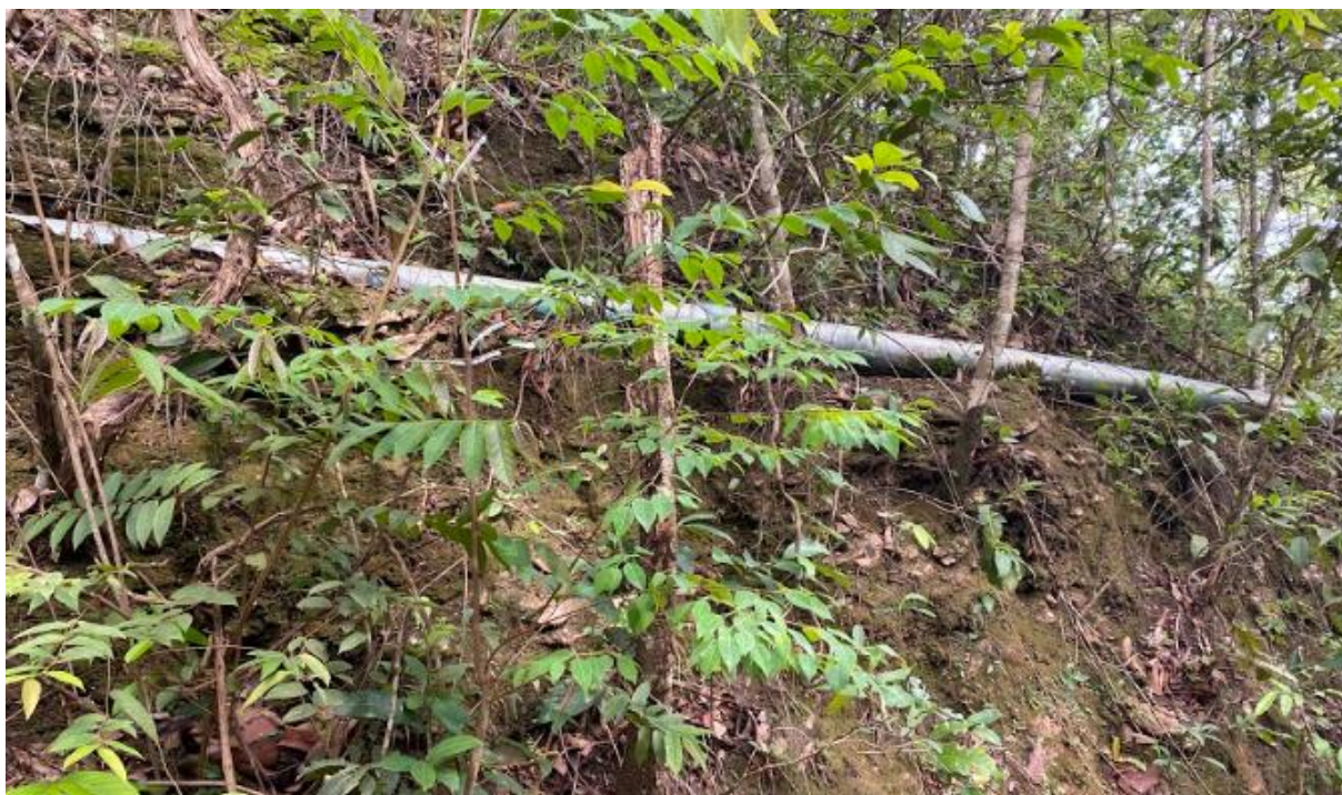
Figura 26 – Adutora de água bruta 03
