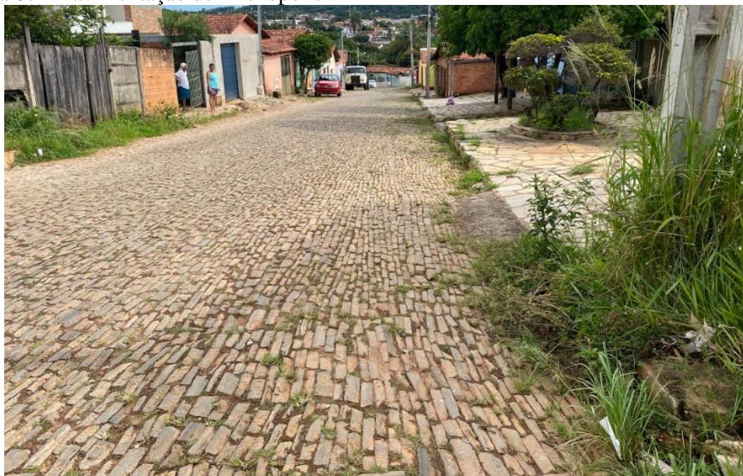
Figura 87 – Pavimentação de Pirenópolis
