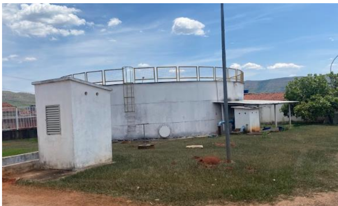
Figura 37 – Reservatório R-3 ETA
