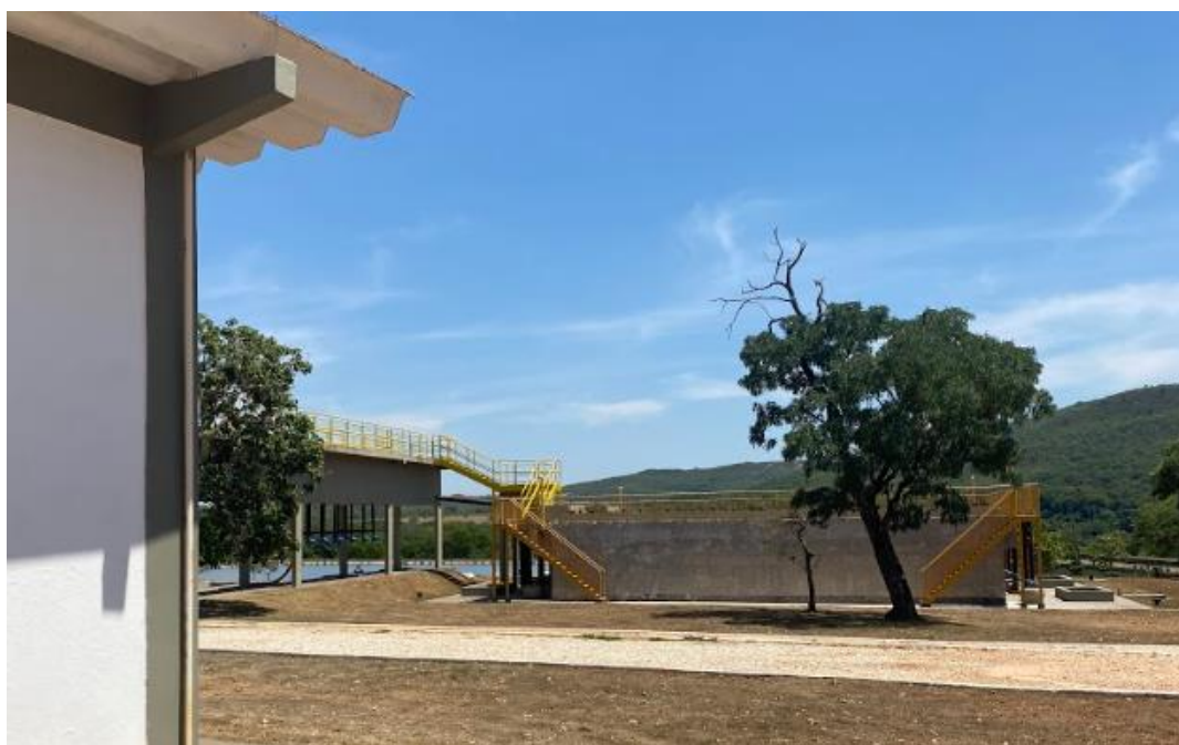
Figura 58 – Estação de Tratamento de Efluente de Pirenópolis
