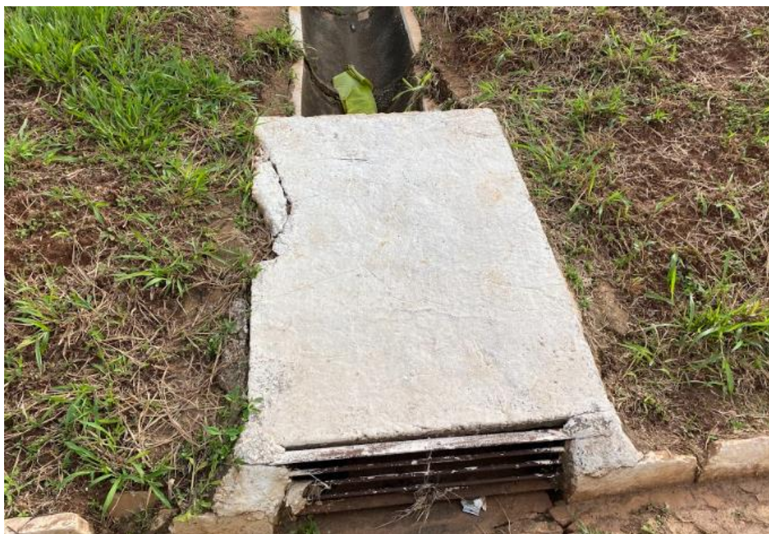
Figura 94 – Canaleta de concreto conjugada boca de lobo
