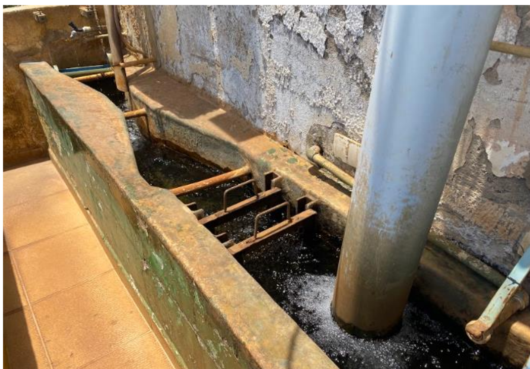
Figura 29 – Calha Parshall ETA Andorinhas
