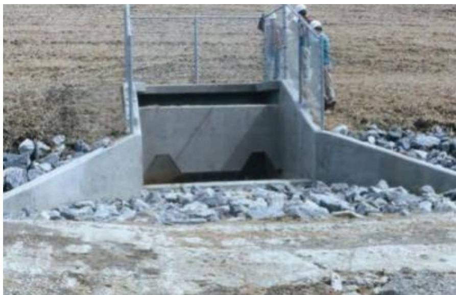
Figura 104 – Dissipador bloco de impacto
