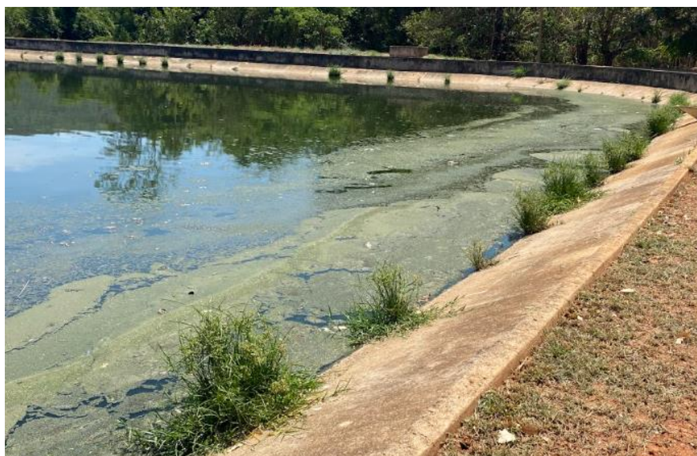
Figura 65 – Acúmulo de material na superfície da lagoa
