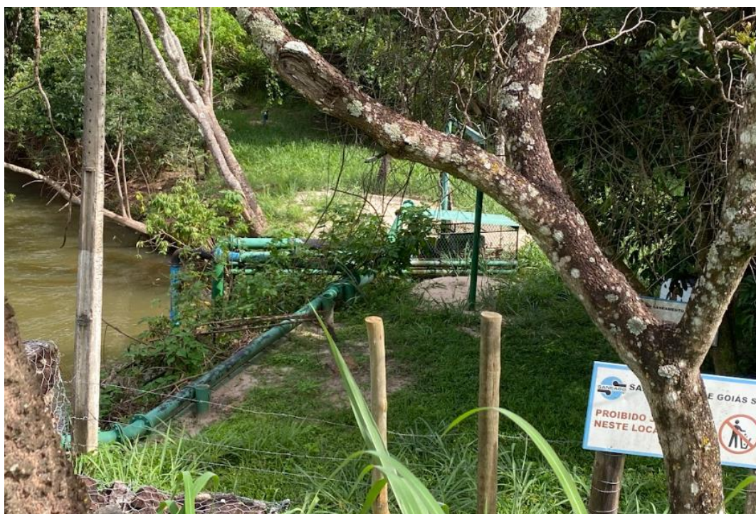
Figura 22 – Captação Rio das Almas II (Sede)
