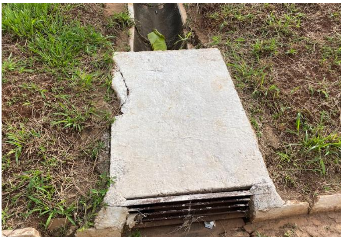
Figura 94 – Canaleta de concreto conjugada boca de lobo
