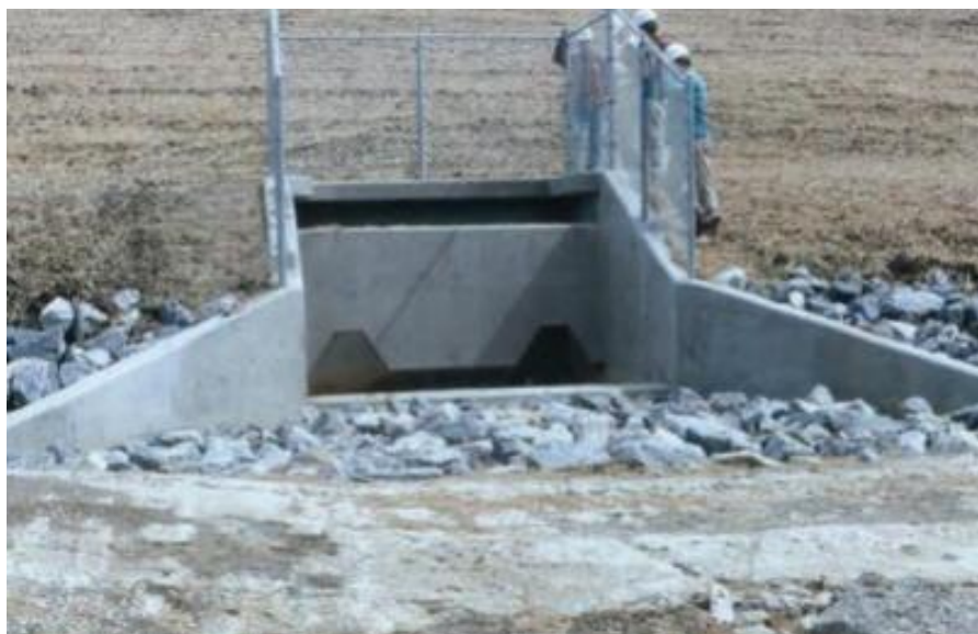
Figura 104 – Dissipador bloco de impacto
