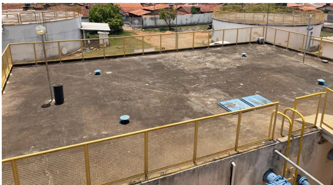
Figura 36 – Reservatórios R-1 ETA
