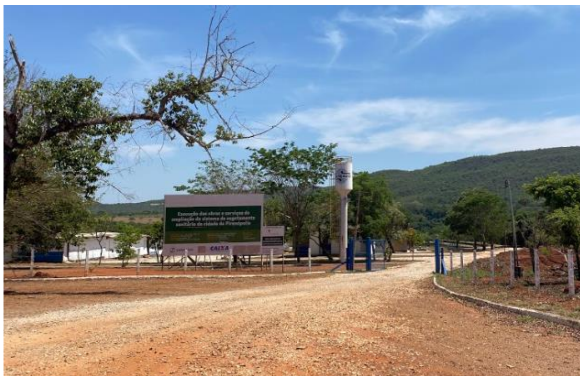
Figura 57 – Entrada da ETE de Pirenópolis
