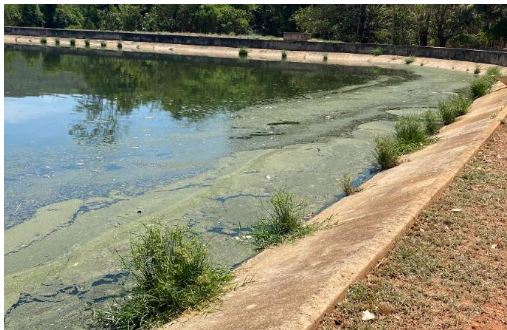
Figura 65 – Acúmulo de material na superfície da lagoa
