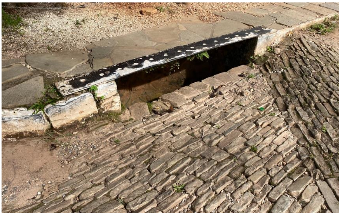
Figura 91 – Boca de lobo lateral
