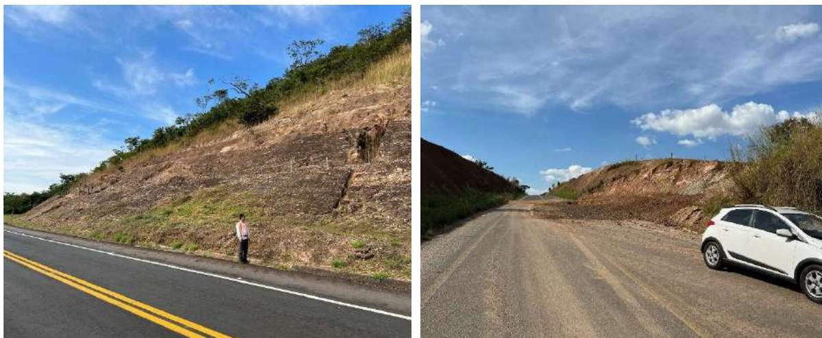
**Figura 6.27:** Cortes de estrada com pontos de erosão (GO-338) e deslizamento de material (GO-479).
