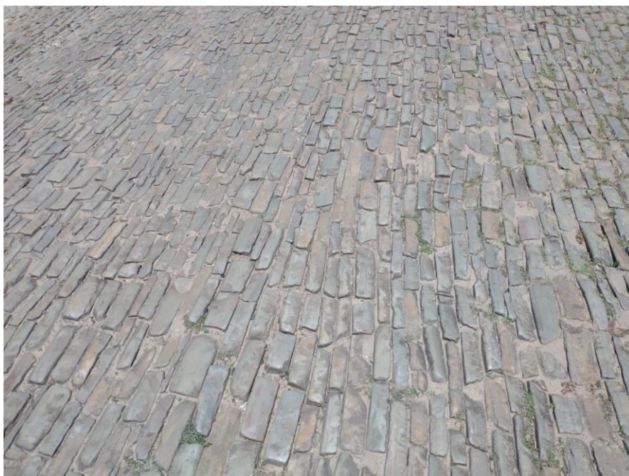
Figura-3: Calçamento Pedras Quartzíticas (retalhos)
