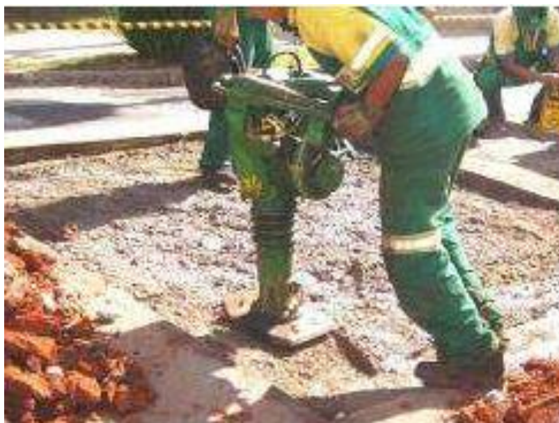
Imagem 22 – Readequação da base
