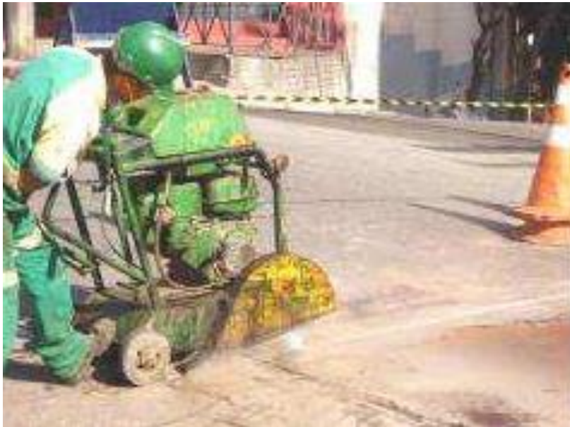
Imagem 21 – Corte do pavimento com cortadora de asfalto
