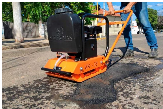
Imagem 19 – Compactação de CBUQ com placa vibratória
